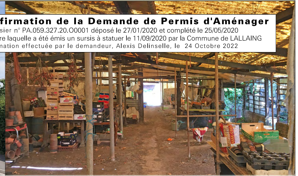
Photo Démolition - Vue 6 - Existant
